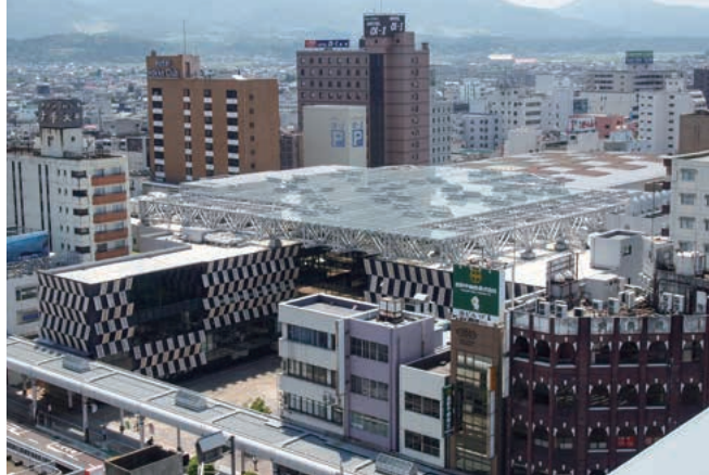
シティホールプラザ「アオーレ長岡」 JR長岡駅前の約1.5haの区域に建つ複合施設。地上4階、地下1階。建築面積 12,066.08㎡
