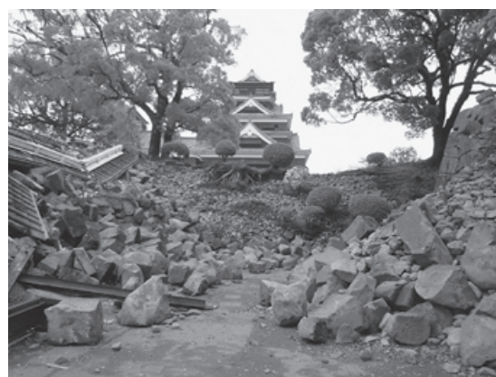
熊本城石垣崩落の様子
