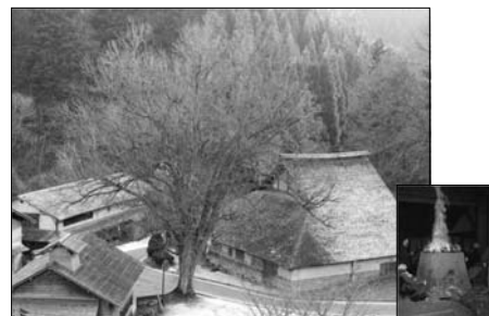
たたら製鉄の遺構;全国唯一の現存する高殿 (菅谷たたら高殿)
