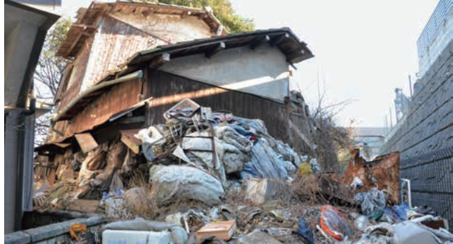
行政代執行前の建築物の状況。左側は隣地建築物。
